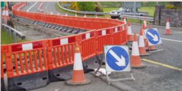
Barrera Base 20 kg ponderada material reciclado HD moldeado su parte superior puede llenarse con agua aumentado otros 15 kg Diseñado para ser apilado compacto y ofrecer bajos costes de transporte Medidas: altura 1000 mm, longitud 1080mm, ancho 520mm, peso 24 kg Fig. 01.01.0056
